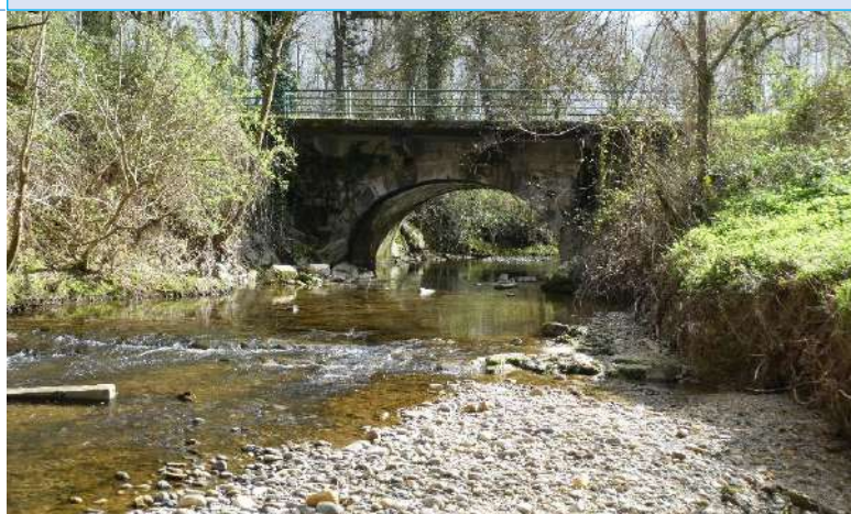
Figure 6 : Passage de la RD 31 par microtunnel
